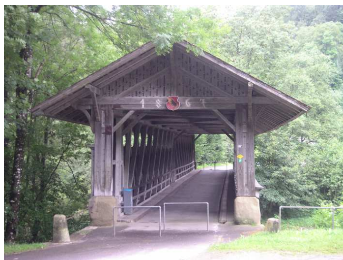
2. Le vieux pont de bois du Sodbach
